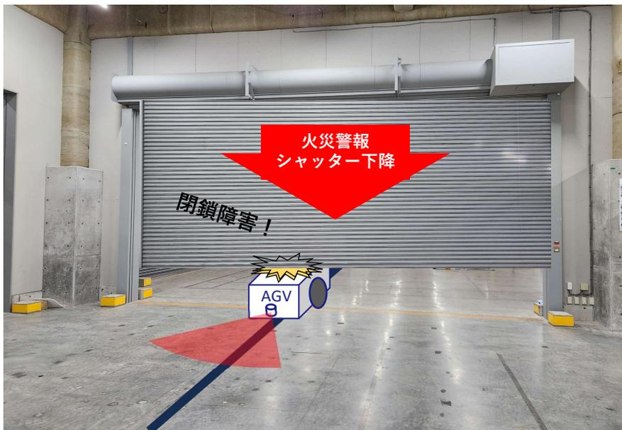
走行中のAGV：自動搬送ロボットが防火シャッターに挟まれてしまう閉鎖障害。AGVは障害物センサーで前を見ていたのに上からの防火シャッター下降到気づかず挟まれることが原因です。この対策には、これまで大規模なシステムを伴う運行管理制御が必要であり、技術的な難易度及び膨大な費用を掛け対策する必要がありました。**KEY×CON SPC**はリーズナブル且つシンプルな制御方法を使った閉鎖障害対策機器です。既存のAGVへの後付け設置も可能で、現場の警防計画の策定に協力できるシステムです。
